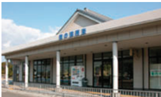
▲陸の港西淡管理棟
